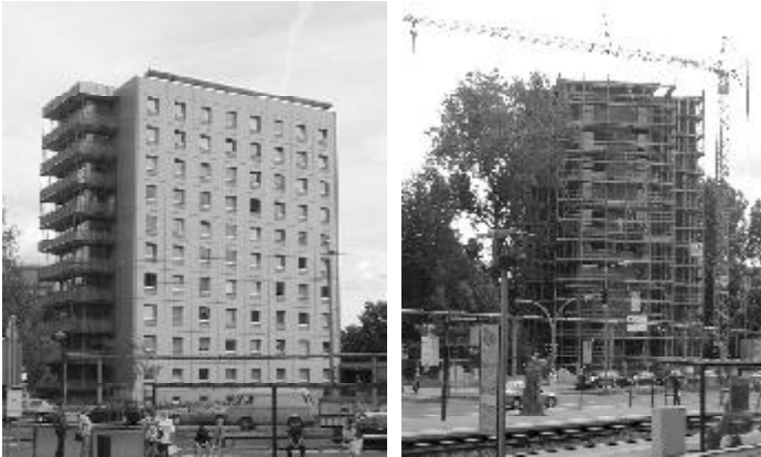
Wohnheime Petersburger Straße, nach und während der Renovierung
