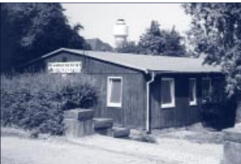
Des StuRa's neues Domizil, die Baracke 1 der TU Dresden
